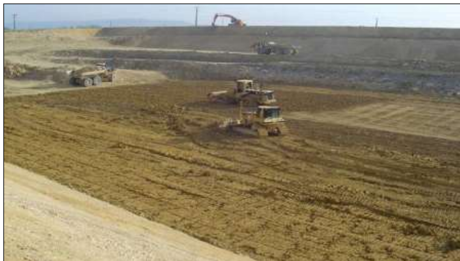
Figure 2 : Exemples de reconstitution de la barrière naturelle en argile
